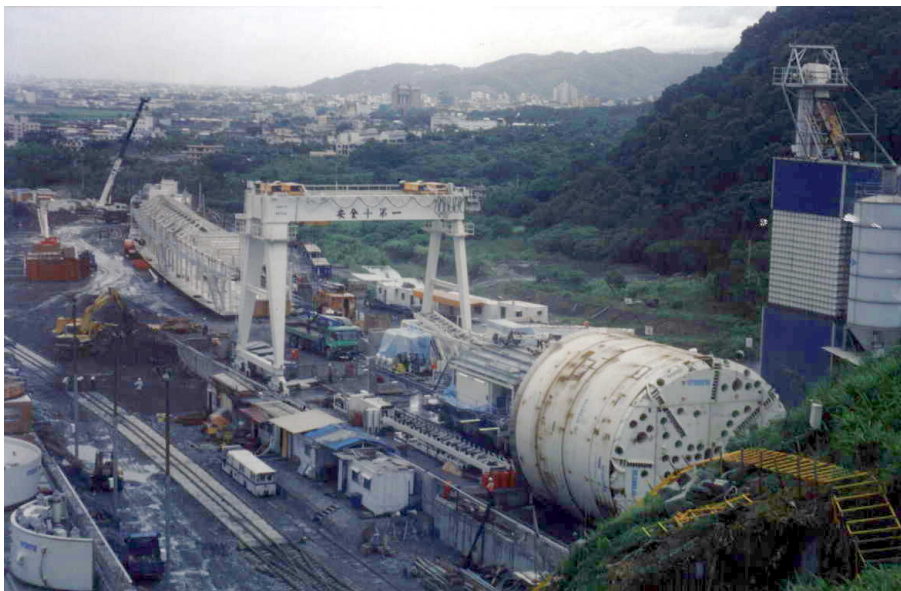
圖 4 主坑 T B M 組裝情形
