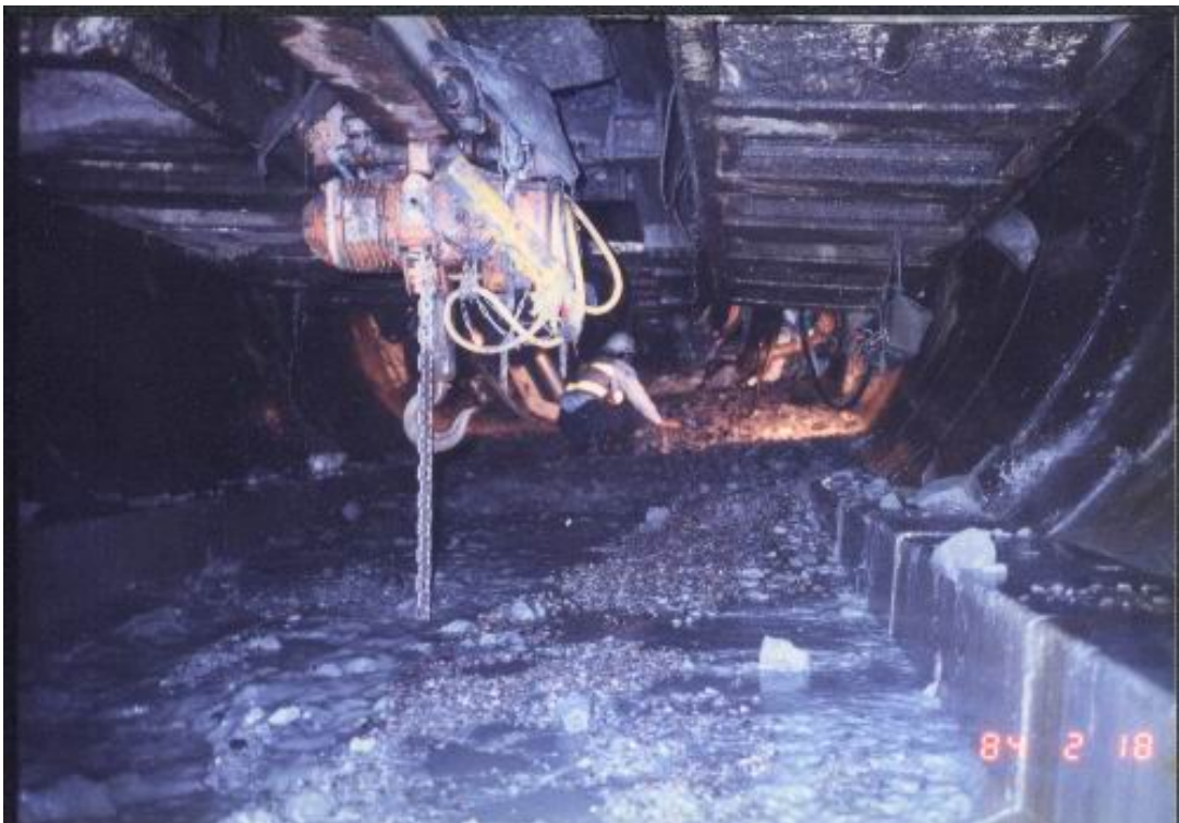
圖 20 抽坍碴料隨地下水湧入TBM料倉
