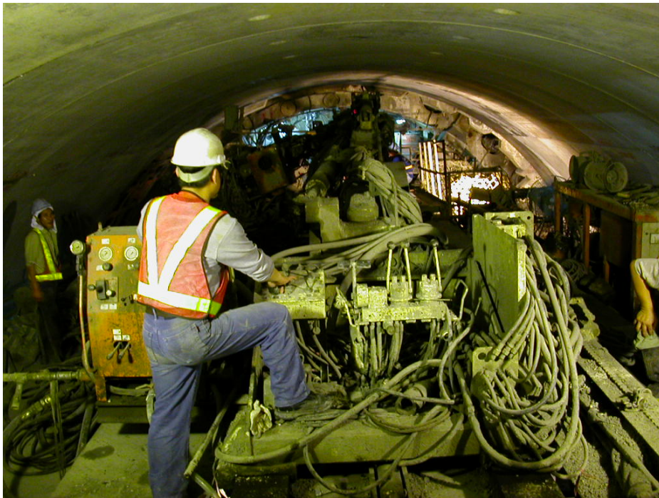
圖 14 主坑 T B M 鑽機施作情形
