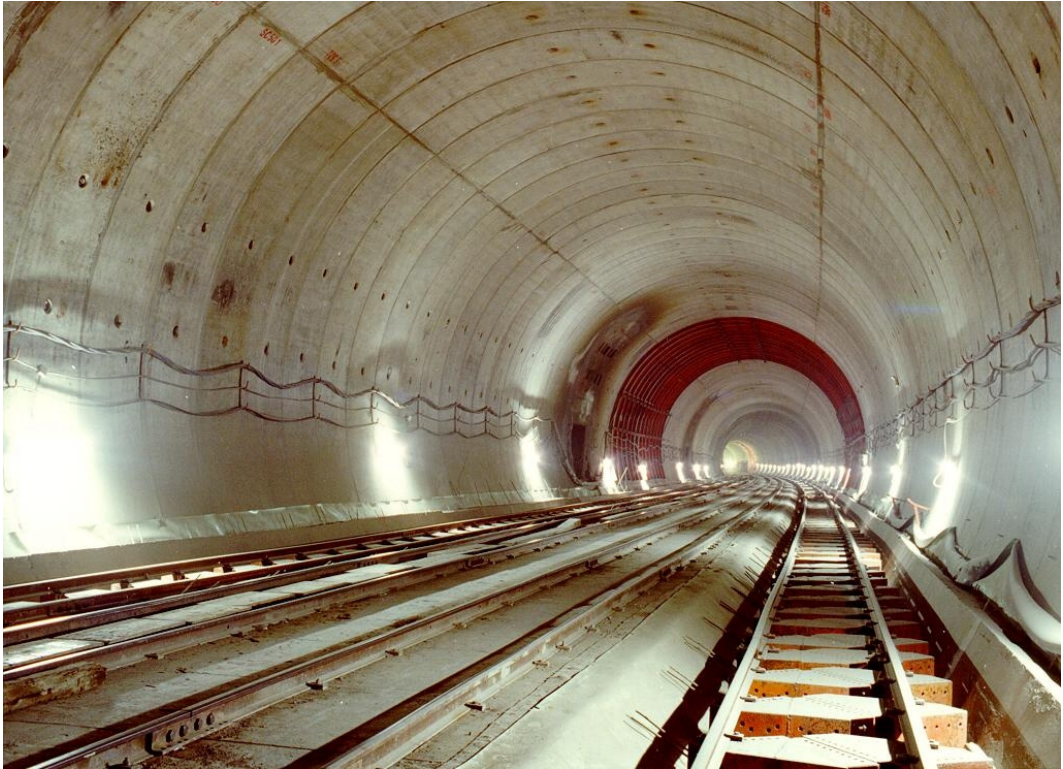
圖 8 主坑 T B M施工完成之情形
