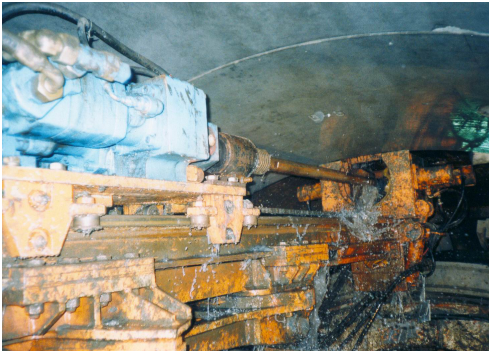
圖 13 導坑施作前進探查
