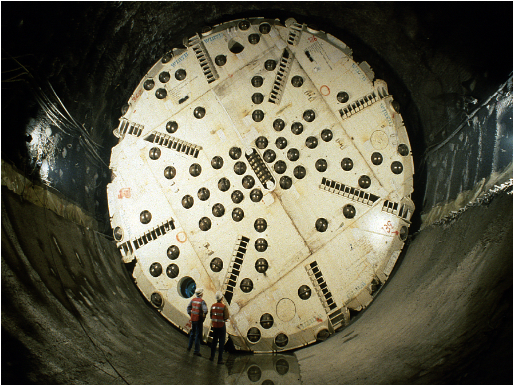
圖 6 主坑 T B M 利用仰拱滑床進洞情形
